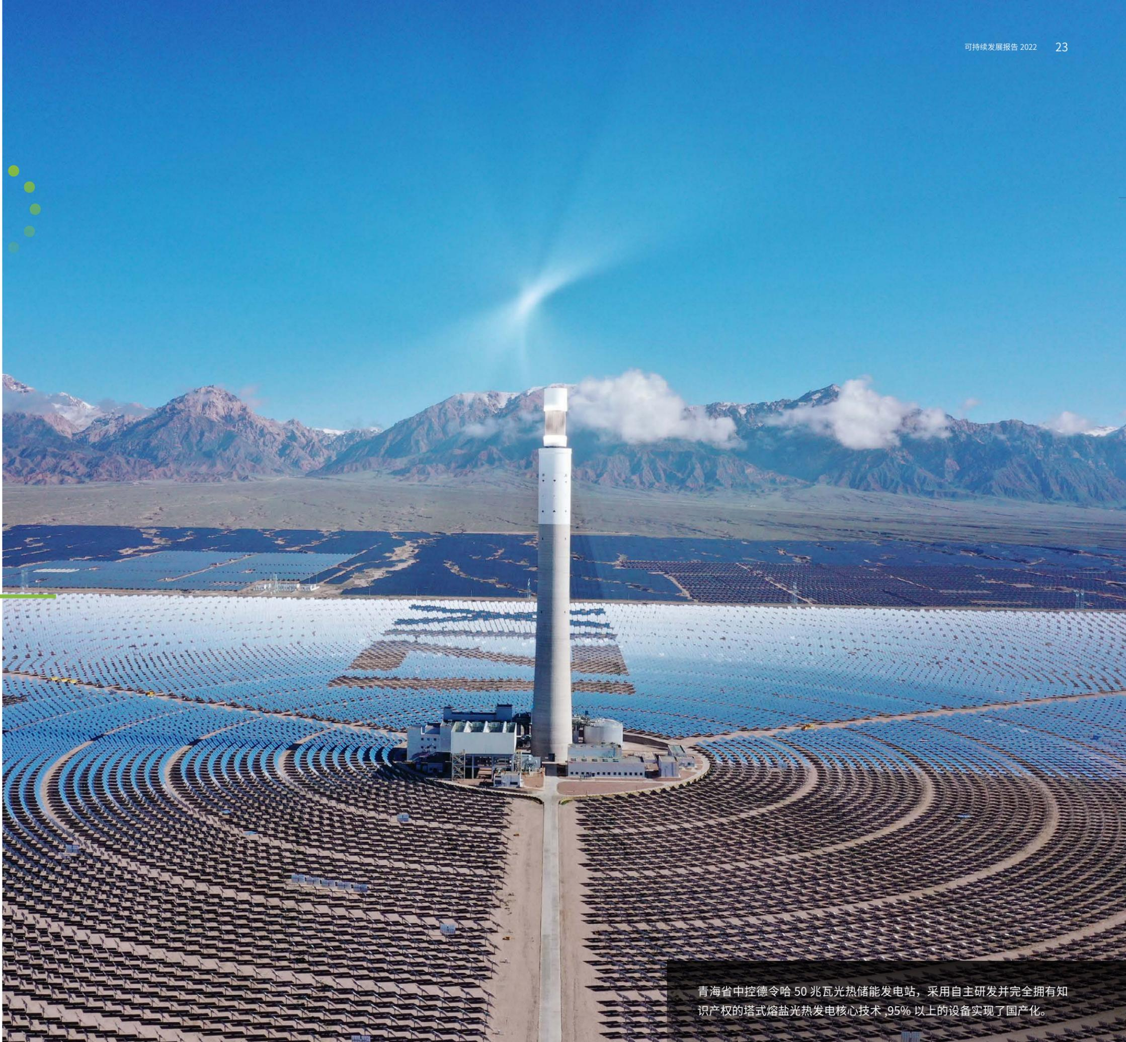
青海省中控德令哈 50 兆瓦光热储能发电站，采用自主研发并完全拥有知识产权的塔式熔盐光热发电核心技术，95% 以上的设备实现了国产化。
